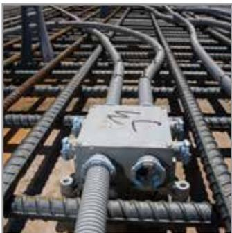
**NAPCO Les emboîtements des boîtiers à encastrer de Solutions pour installations électriques sont en élévation, pour une barre d'armature de diamètre plus élevé.**
