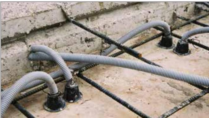
Diagramme 2. ENT noyé dans le béton.
