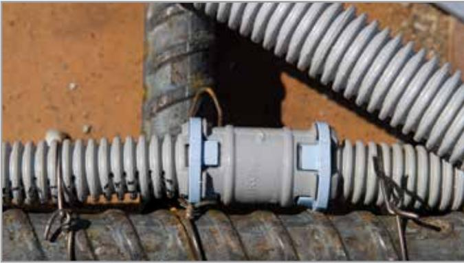
Diagramme 1. Tuyau ENT fixé au moyen d'un raccord et fixé à une barre d'armature.
